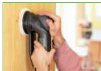
Het polijsten van met was bestreken vlakken.
