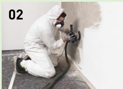
Aangetaste delen van het pleisterwerk en oude lagen afnemen met de renovatiefrees.
