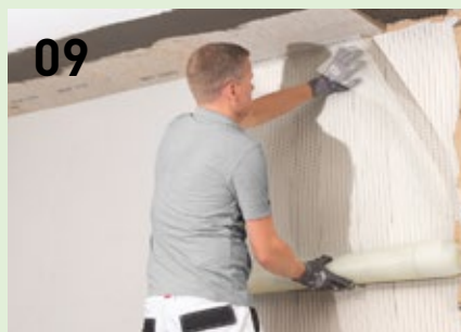
Met het strijkbord in verticale banen zonder rimpels en overlappend wapeningsnet in de wapeningsmortel aanbrengen.
