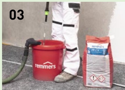
PP Fix, een speciale hechtmortel voor schimmelsanering, aanmaken met Festool-mengmachine MX 1200 en spiraalgarde HS3L.
