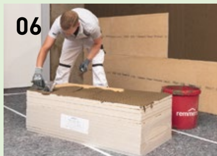
Voor een volledige hechting op de isolatieplaten wordt PP Fix met een getande spaan op wanden en platen aangebracht.
