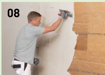
Vul de aan de muur bevestigde isolatieplaten over het gehele oppervlak met een getande spaan en PP Fill.
