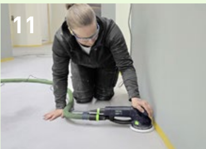
11 Slijp het hele vloeroppervlak: grote vlakken met een Trio excenterschuurmachine, in de randgebieden en op moeilijk toegankelijke plekken met de ROTEX RO 150 of RO 90.
