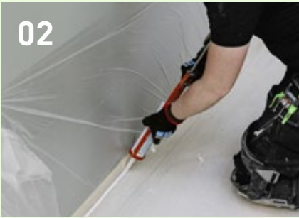
02 Dicht de voegen tussen randisolatiestroken en vloer met acryl afdichtingsmateriaal af.
