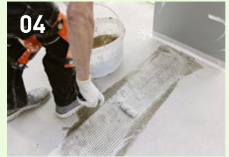
04 Leg golfverbinders in de freessleuven en sluit alles met een hars af. Breng aansluitend glasvezelweefsel aan en zand met kwartszand af.
